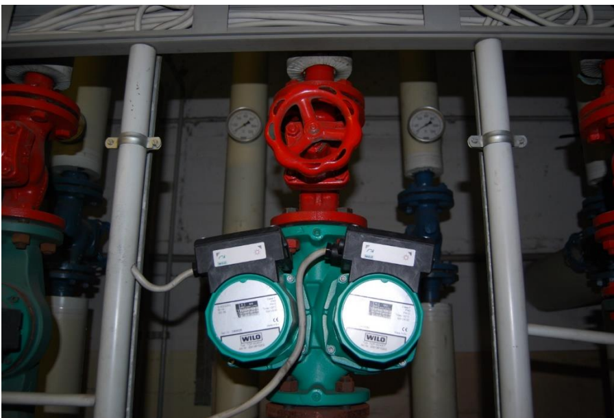
Abbildung 14: Zwillings- oder auch Doppelpumpe, rechts Prinzipdarstellung (Bilder: BSI)
