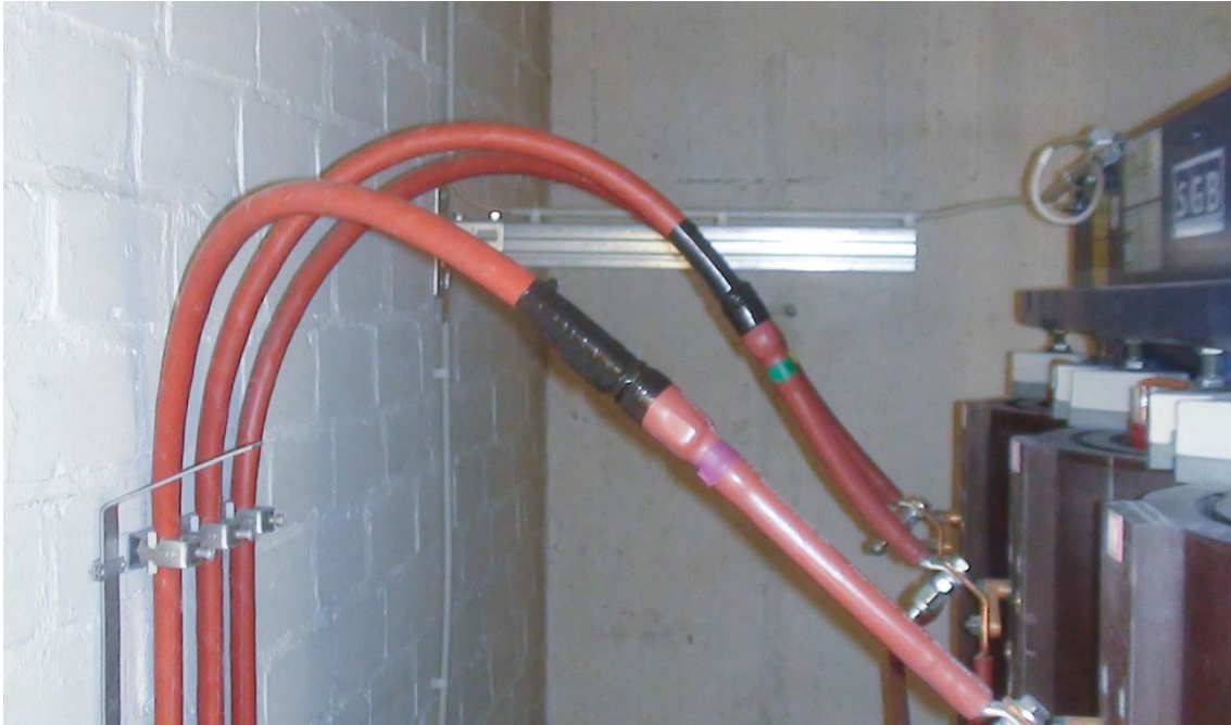
Abbildung 23: Gekappte und nicht aufgelegte Schirmung der MS-Kabel (Bild: Karl-Heinz Otto)
