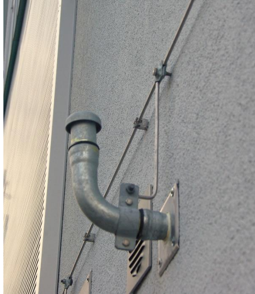
Abbildung 39: Falscher Anschluss einer Tankentlüftung an den Blitzschutz (Bild: BSI)
