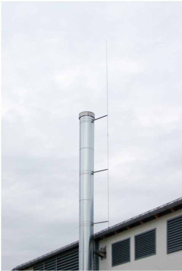
Abbildung 35: Korrekt aufgebauter Blitzschutz im linken Bild. Im rechten ist der Blitzschutz falsch realisiert. (Bilder: BSI)
