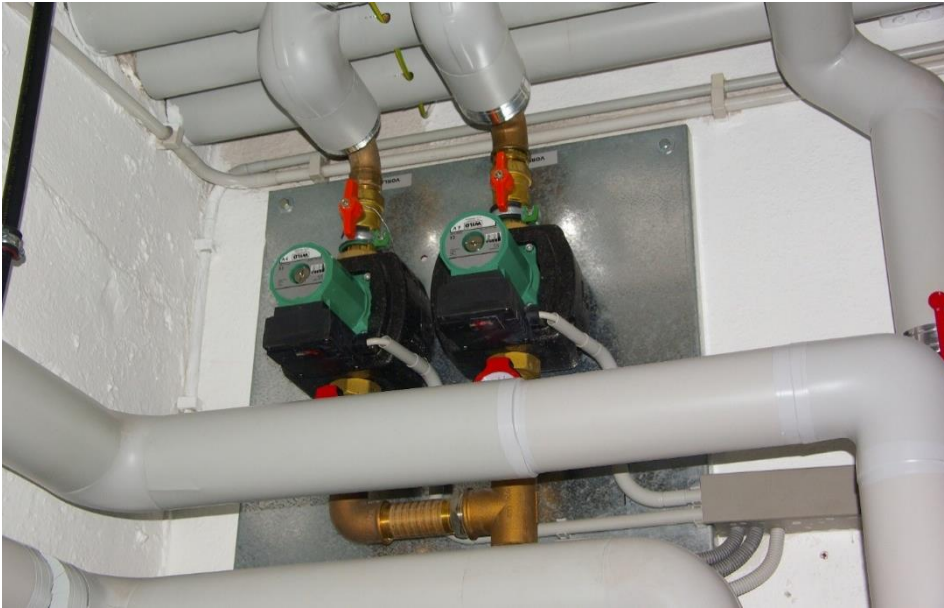
Abbildung 15: Zwei, einander Redundanz gebende Pumpen, rechts Prinzipdarstellung (Bilder: BSI)
