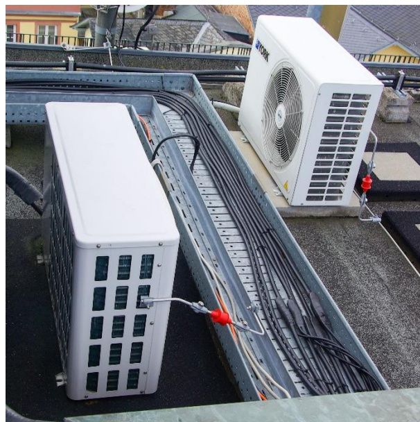
Abbildung 37: Korrektur ausgeführter Blitzschutz im linken Bild und falsch ausgeführter Blitzschutz im rechten Bild (beide Bilder: BSI)
