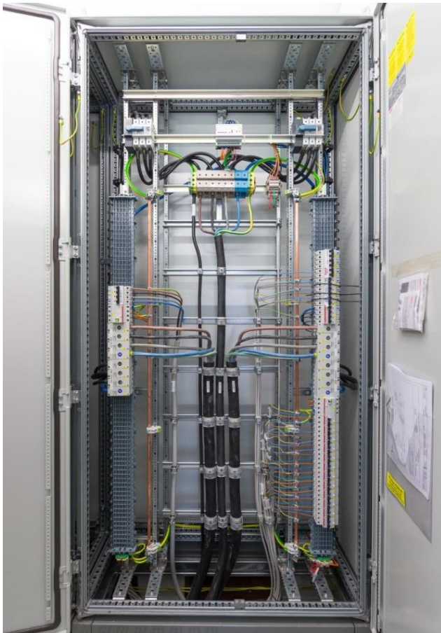
Abbildung 5: Moderne, EMV-gerechte und den Erfordernissen hoher Verfügbarkeitsansprüche der IT genügende Verteilungen (Bilder: Werner Henke)
