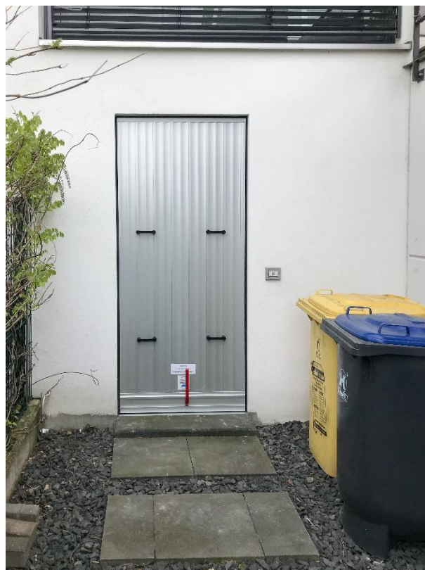
Abbildung 19: Mobiles Wasser-Schutzsystem ohne Sickerwasser-Eintrag (Bild: Kirschbaum GmbH)
