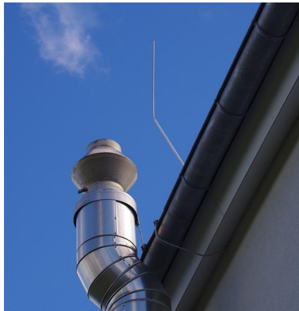
Abbildung 36: Fehlerhaft ausgeführter Blitzschutz (Bild: BSI)
