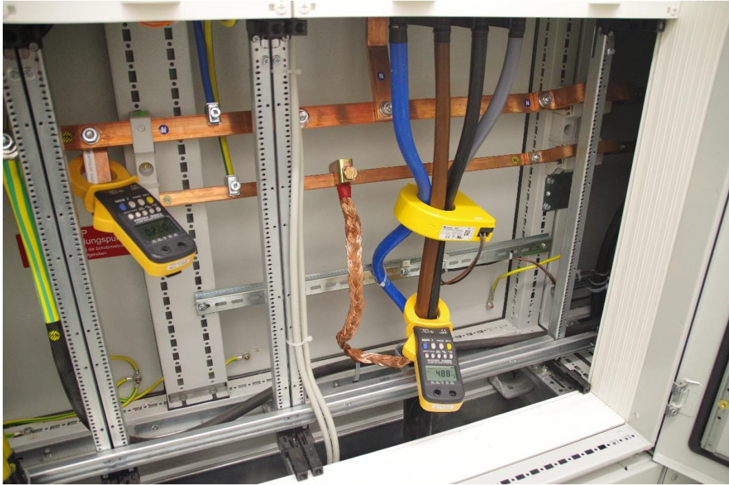
Abbildung 6: Sachgerechter Aufbau der Zuleitung zu einer Hauptverteilung. Das linke Messgerät ist am ZEP angelegt. (Bild: BSI)
