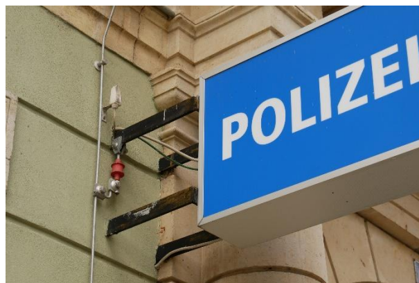
Abbildung 40: Falscher Anschluss an die Fangeinrichtung mittels Trennfunkstrecke (Bild: BSI)
